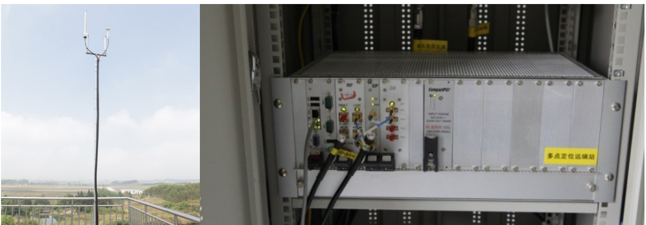
桂林机场多点定位系统现场建设情况
